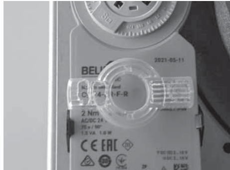
Abb. 3.19 Kupplung entriegelt
