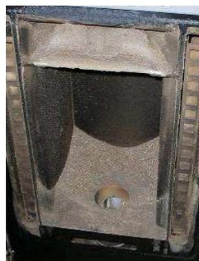
Abb. 111: Normale Verschmutzung (trockene Flugasche).
