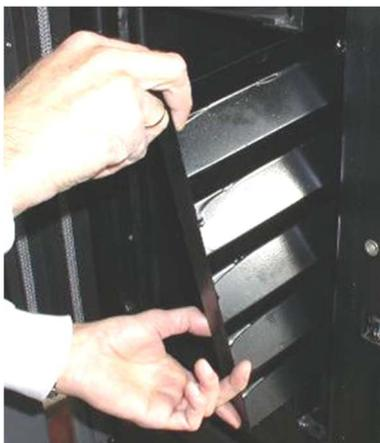
Abb. 135: Entnahme Turbulator
