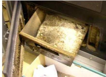
Abb. 110: Entnahme der Aschelade
