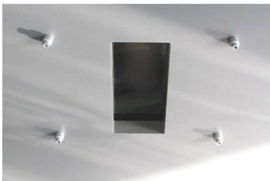
Abb. 38: Glashaltebolzen eingeschraubt
