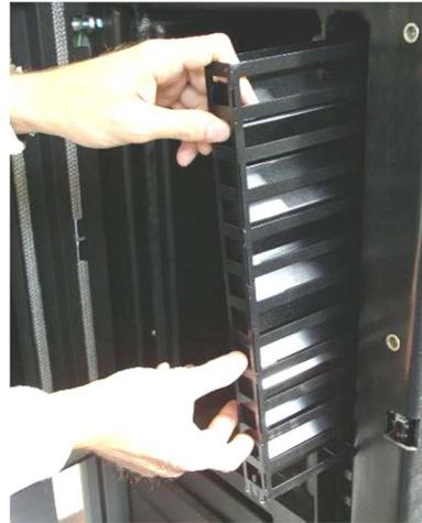
Abb. 136: Entnahme WT- Reinigung
