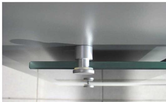
Abb. 41: Dekorglas montiert
