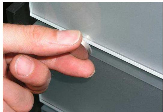
**Abb. 36: Detail Verschraubung Dekorglas**
