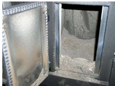
Abb. 95: Verschmutzter Feuerraum
