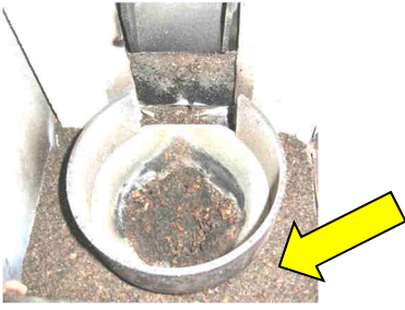
Abb. 25: Asche im Brennraum
