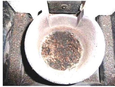
Abb. 27: Rost verschmutzt
