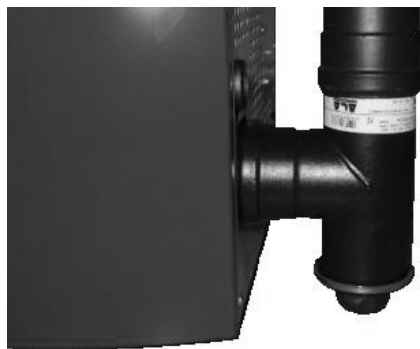
Fig. 32 - Reinigung des Rauchgaskanals
