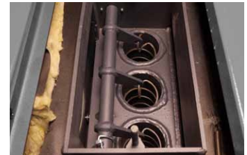
Abb. 6: Leitungen des Rohrbündelwärmetauschers mit Turbolatoren
