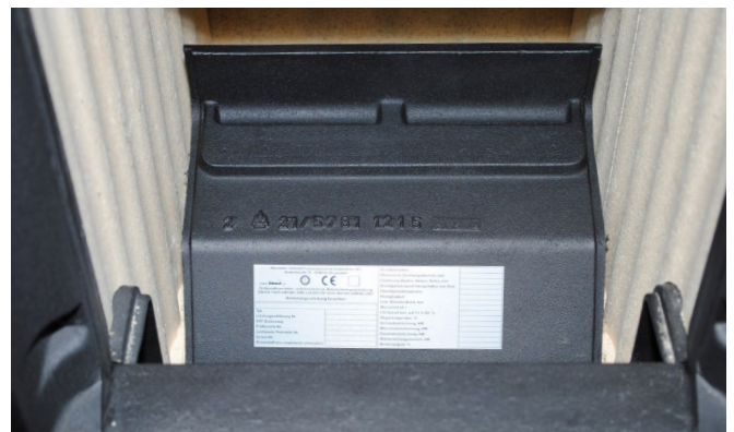
Abb. 2: Typenschild auf Luftkanal vorn im Feuerraum
