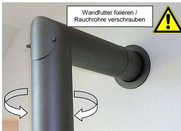
Abb. 18: Anschluss Rauchrohr an Wandfutter
