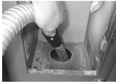
Fig. 39 - Reinigung Fach Brennschale
